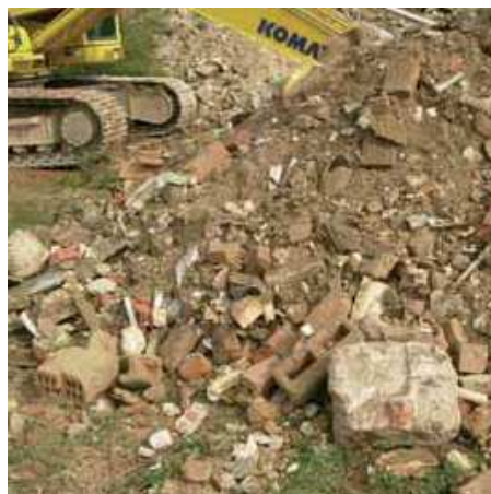
stavební suť z cihel a výkopové zeminy
